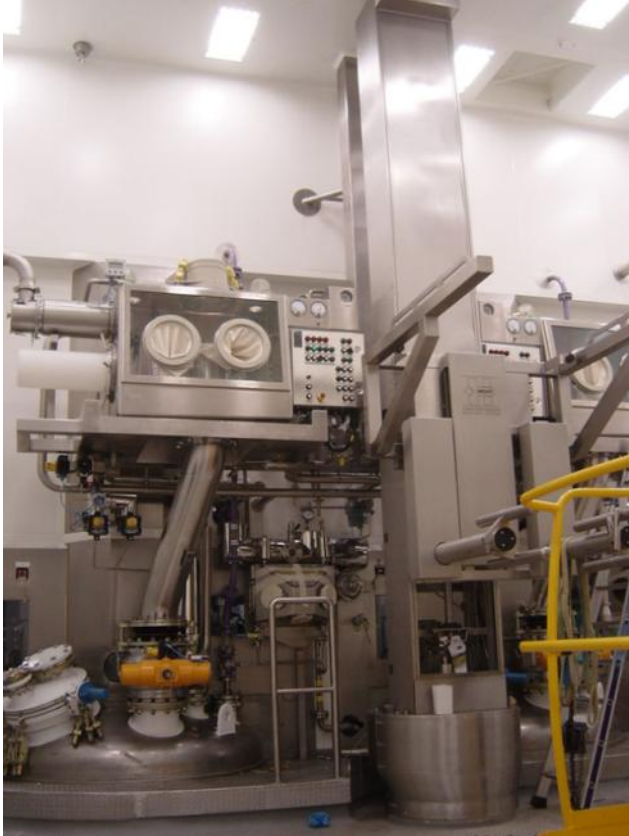
Abb.: Reaktorbefüllung mit Hubsäule
